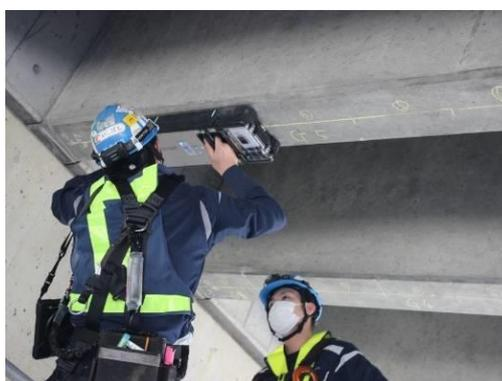
非破壊検査技術を使用した点検
